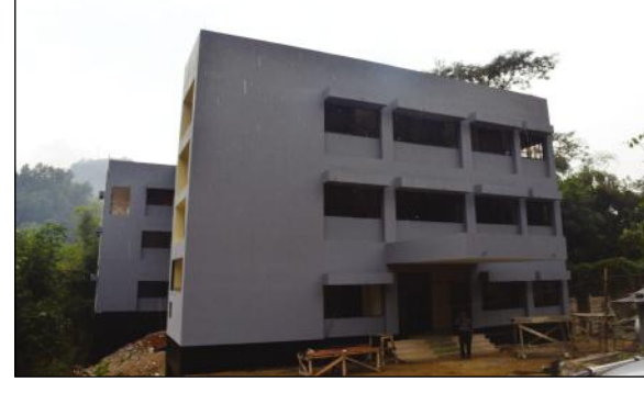
রুমা আঞ্চলিক কেন্দ্রের নবনির্মিত ভবন
